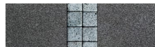
NÄKÖVAMMAISTEN HUOMIORAITA (OHJAAVA RAITA): Kaksi harmaata lohkoktua noppakiveä rinnakkain ladottuna.
